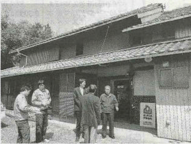
耐震診断が行われた豊川市の古民家
